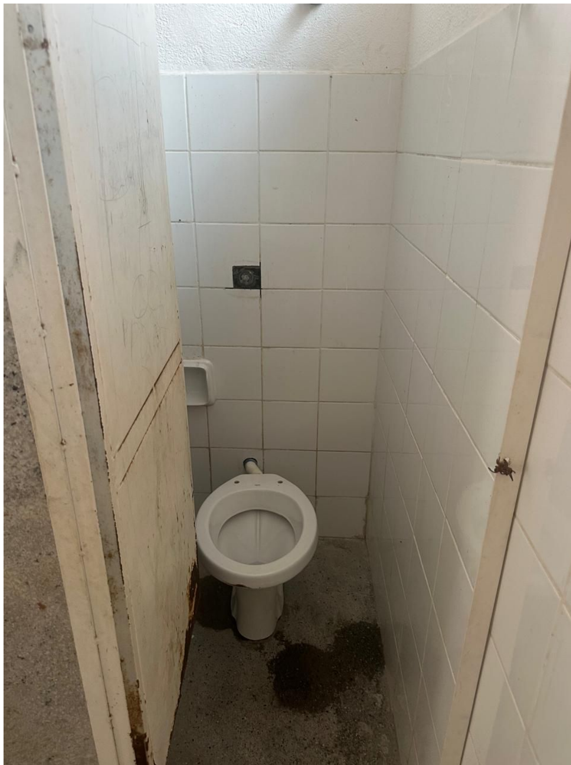
Foto 11 – Porta Banheiros danificada e Válvula.
